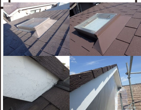
施行前 ➤ 施工後
