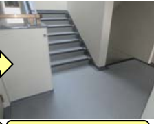
長尺シート施工
