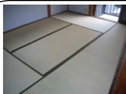
①既存の畳を撤去・処分
