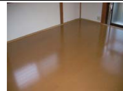
③仕上材(木質フローリング)施工
