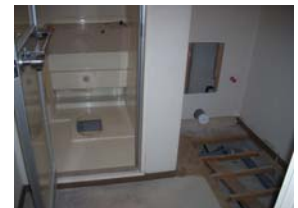
便器を取り外し、排水管を移設
