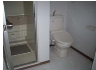
☆床の補修と便器新設☆
