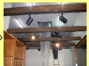
②エアコン周囲の養生
