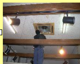
④エアコン内部高圧洗浄
