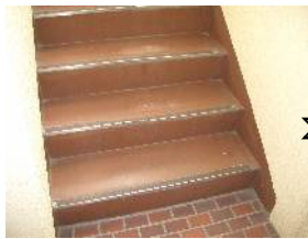
①経年によりトップ塗装が剥がれたり、割れたりして
