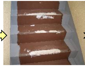
②縁、溝部分に防水ウレタン塗装。既存ステップ撤去。
