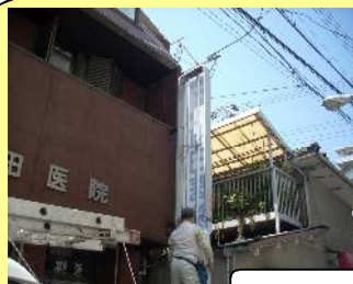
古い看板の撤去
