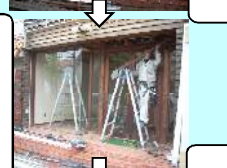
スラット取付
