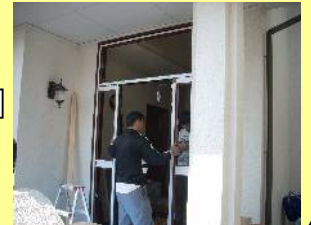
【新しい枠の取付】
