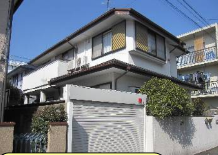
【高原様邸】 豊中市服部本町1丁目 木造・スレート葺 モルタル塗・2階建
