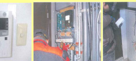
制御装置交換
