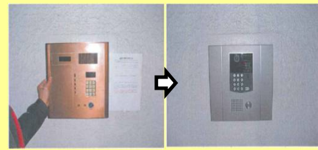
エントランス集合玄関機交換
