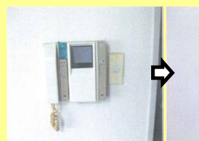
住戸インターホン親機交換
