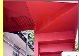
②エポキシ錆止め
