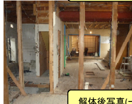
解体後写真(一部)
