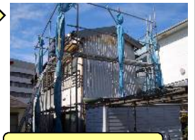
②足場架設
