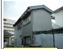
④壁を張替・完成！
