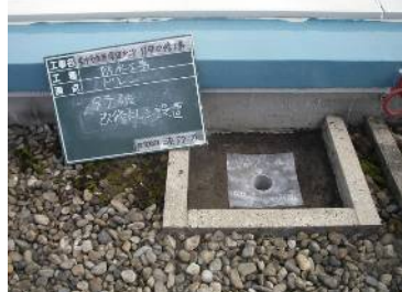
①改修ドレン設置
