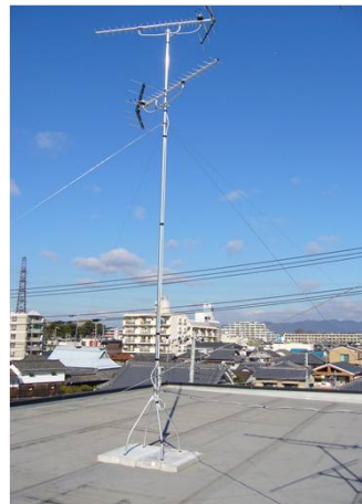
屋上アンテナ新設
